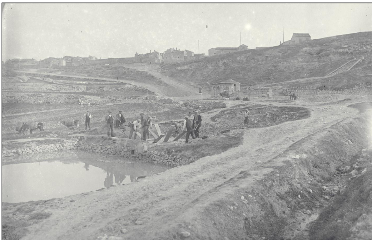
Lam. 10. Nivel del pontiense en Colmenar de Oreja y balsas para la preparación de la arcilla.
