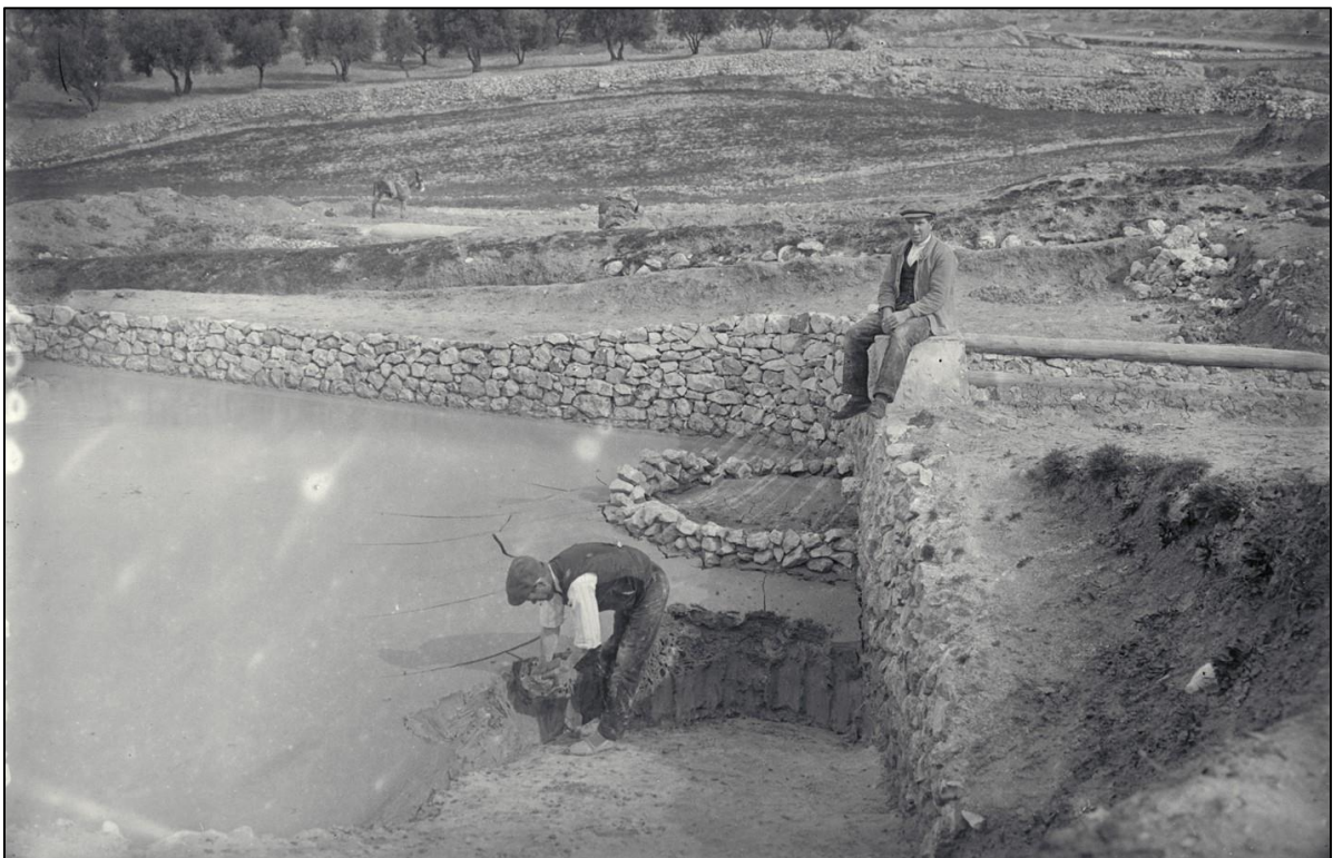
Fig. 18. Arcilla miocena sedimentada en las balsas para su empleo en la fabricación de tinajas en Colmenar de Oreja
