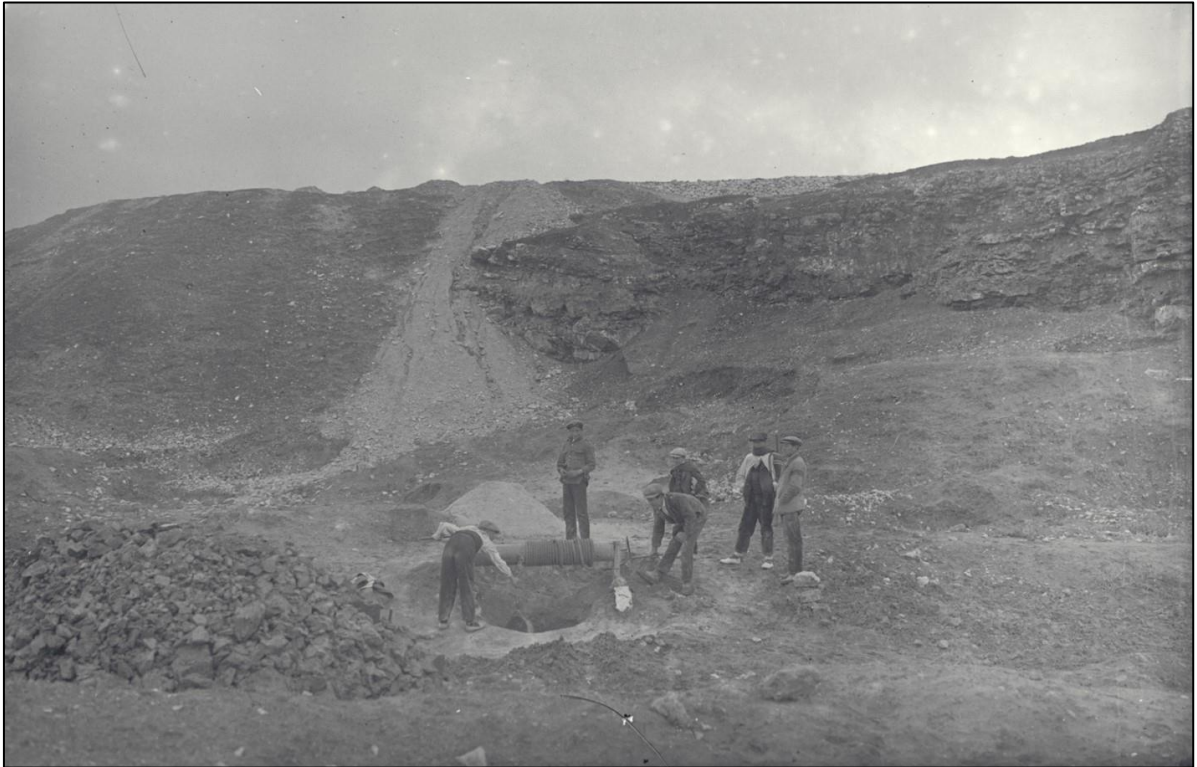
Fig. 17. Pozo para la extracción de las arcillas situadas bajo los bancos de caliza de los páramos y empleadas para la fabricación de tinajas en Colmenar de Oreja.
