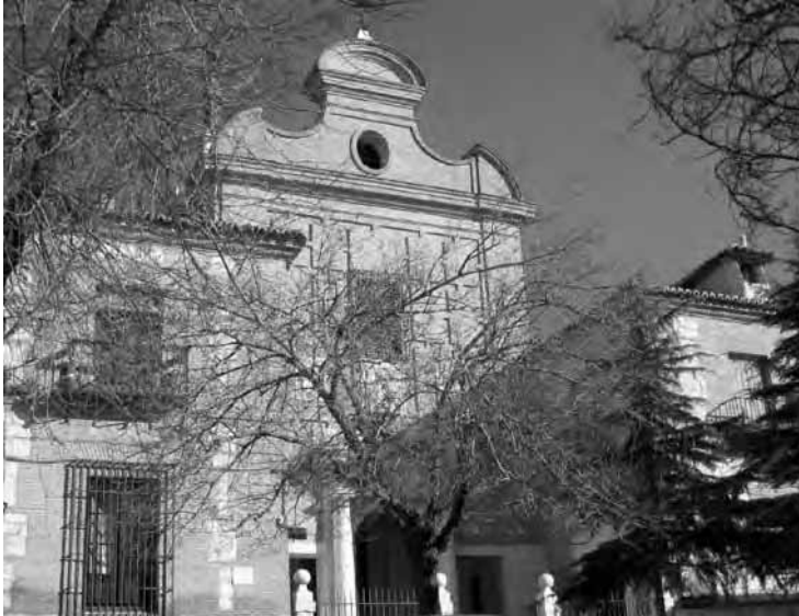
Convento de Agustines Recoletas. Vista Frontal de la entrada. Fachada Iglesia ©, Cuarto del Patrón (I) y Cuarto del Capellán Mayor (D). Traza de Fray Lorenzo de San Nicolás, OAR. 1640. Colmenar de Oreja. Madrid
